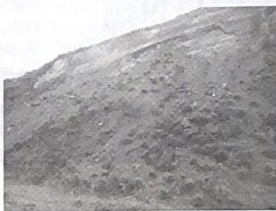
图1 隧道进口边坡全景
